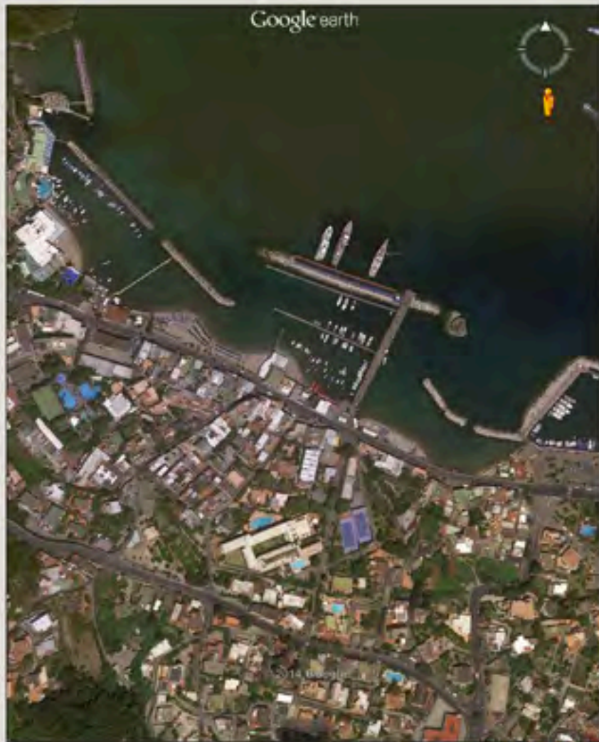
spiaggia del CORSO
